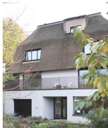
1 er prix cat. B - Vanden Eeckhoudt-Creyf - Avenue du Maréchal 35
