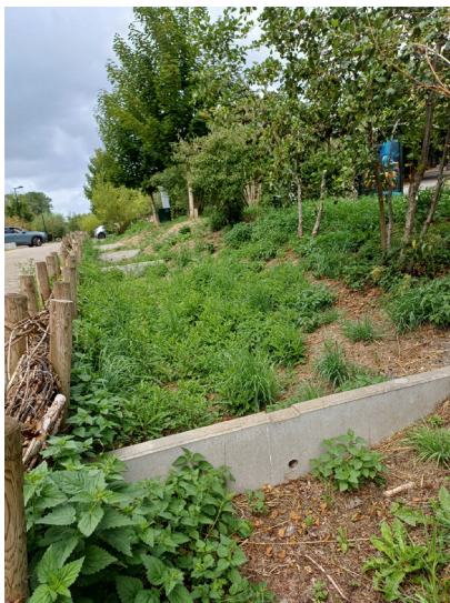
Murets de bief dans le jardin de pluie (nouvelle photo 21072025)
